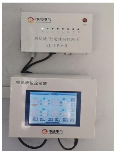
泄漏检测仪+液位控制器
