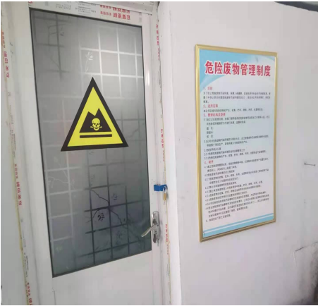
危废暂存间外部
