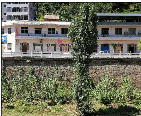
已建堤防的河段现状
