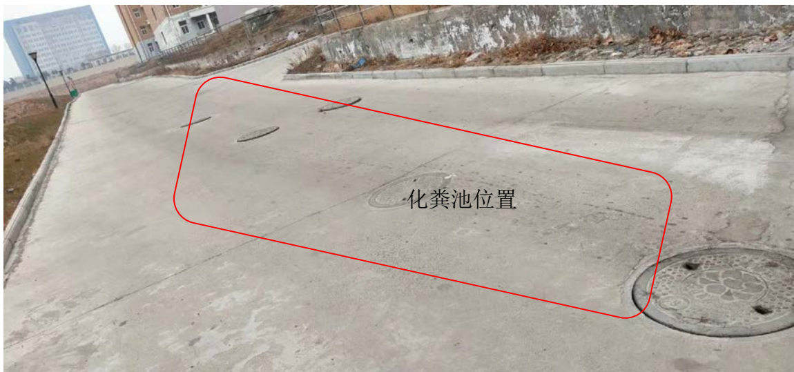
厂区共用化粪池
