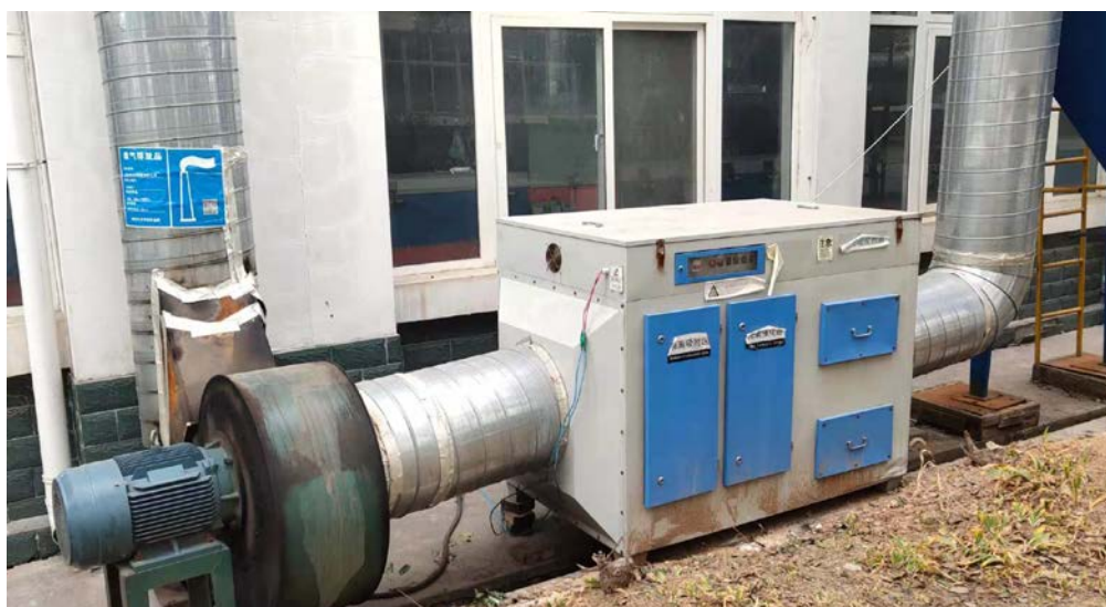
除尘器+UV 光氧催化+活性炭吸附 装置+20m 高排气筒设置情况
