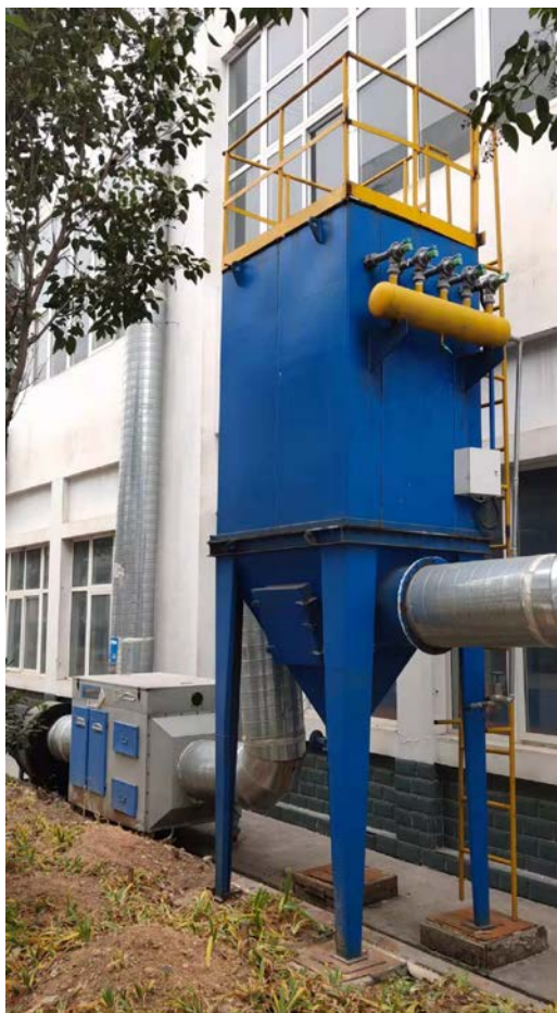
除尘器+UV 光氧催化+活性炭吸附 装置+20m 高排气筒设置情况
