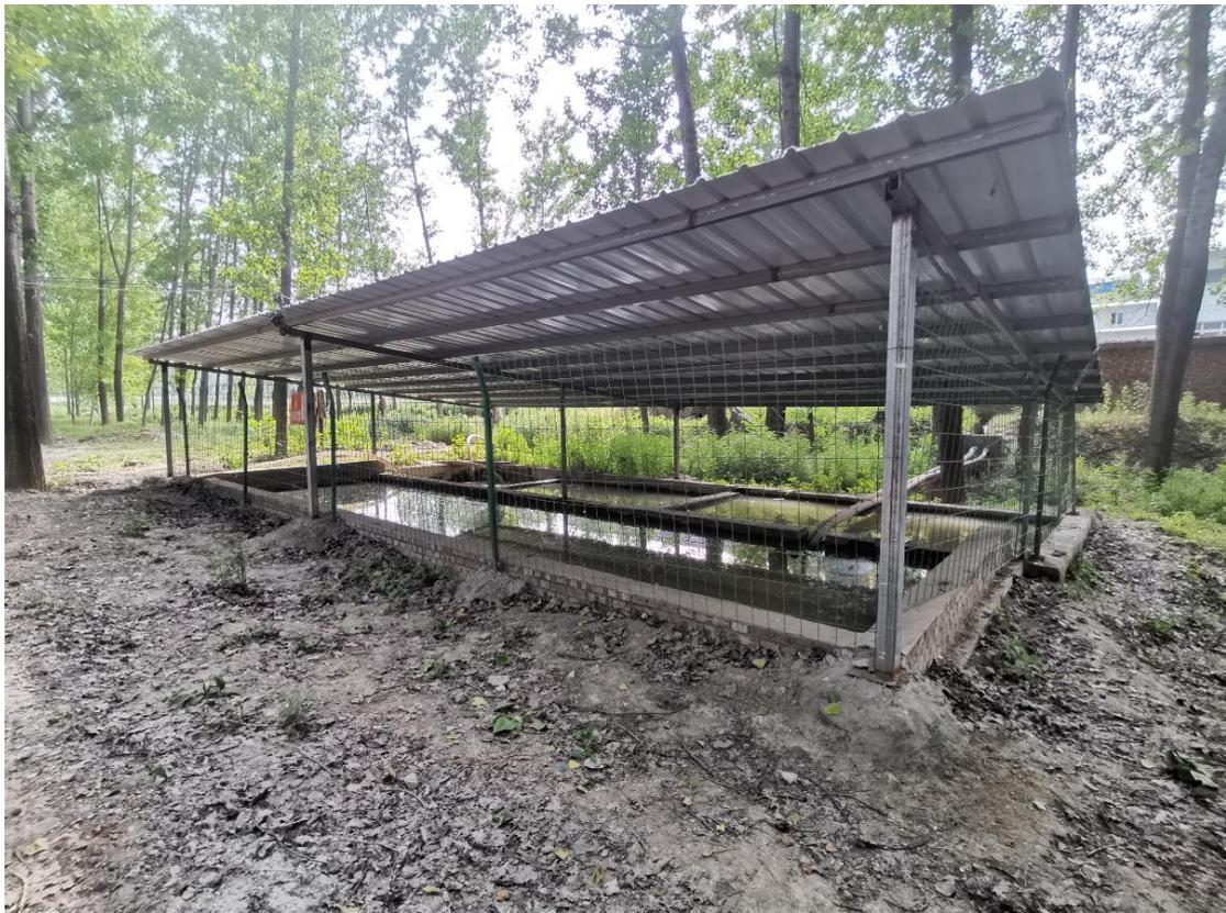
图5 废水治理设施(精矿渗滤液收集池)
