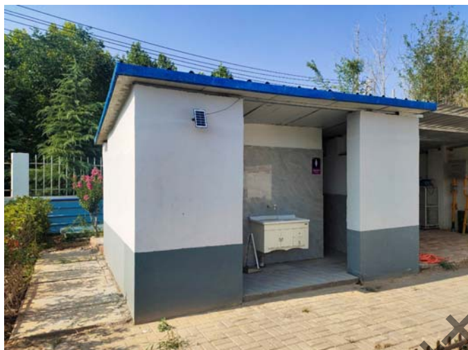
化粪池所在区域
