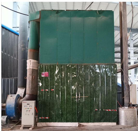
除尘器下部封闭
