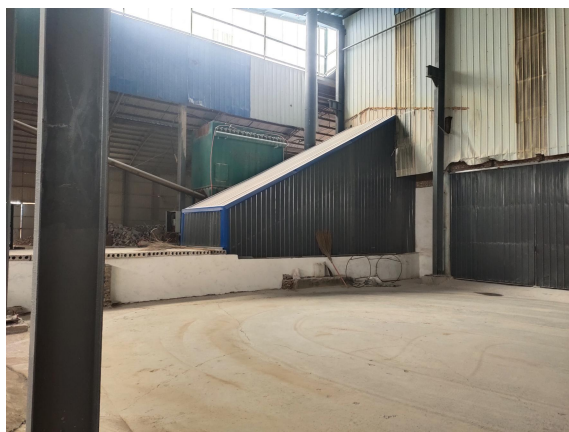
封闭皮带廊道
