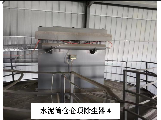
水泥筒仓仓顶除尘器 1
