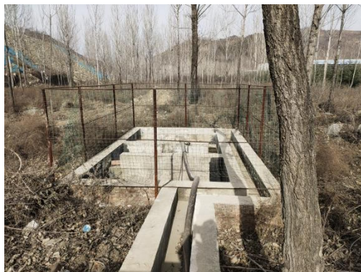
车辆冲洗沉淀池
