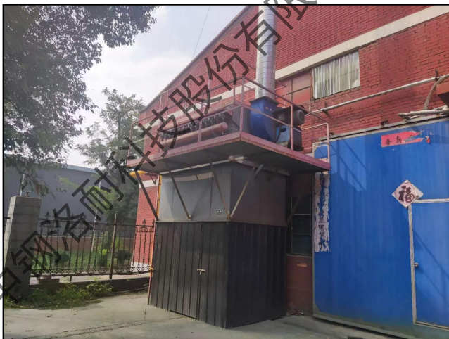
海奥分厂混料工序除尘器
