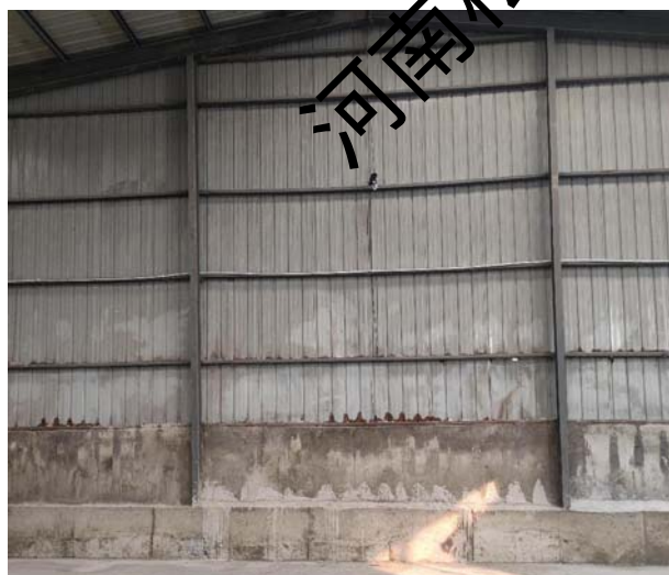
项目原料区喷淋装置
