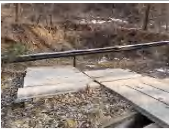
初期雨水收集池
