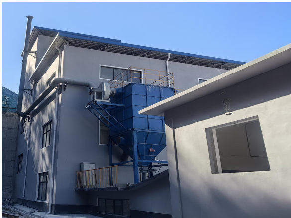
鄂破处袋式除尘器
