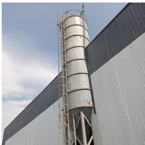
骨料干燥筛选、沥青废气排气筒
