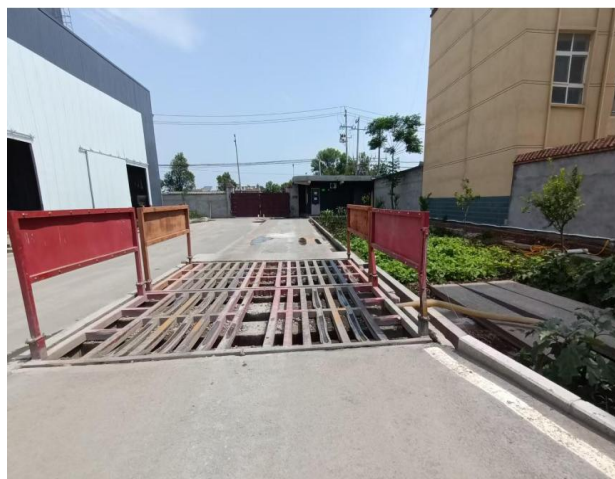
车辆冲洗装置+沉淀池
