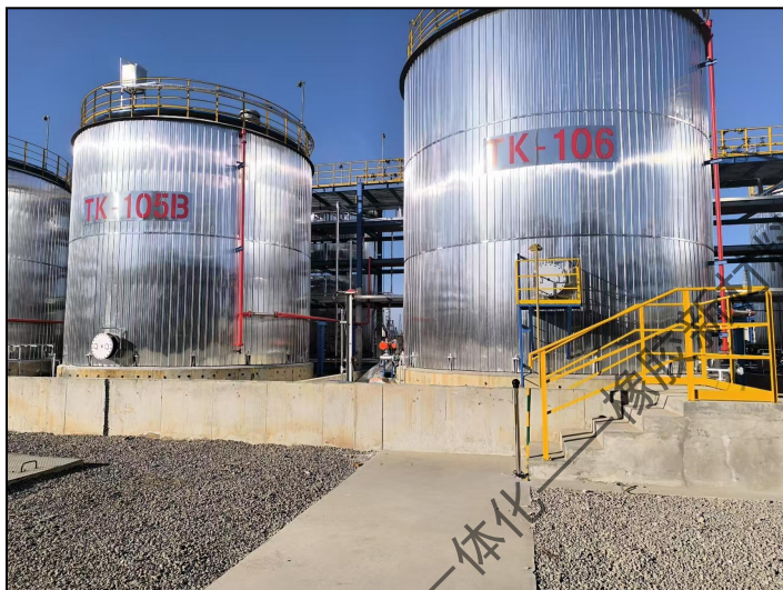
储罐区围堰
