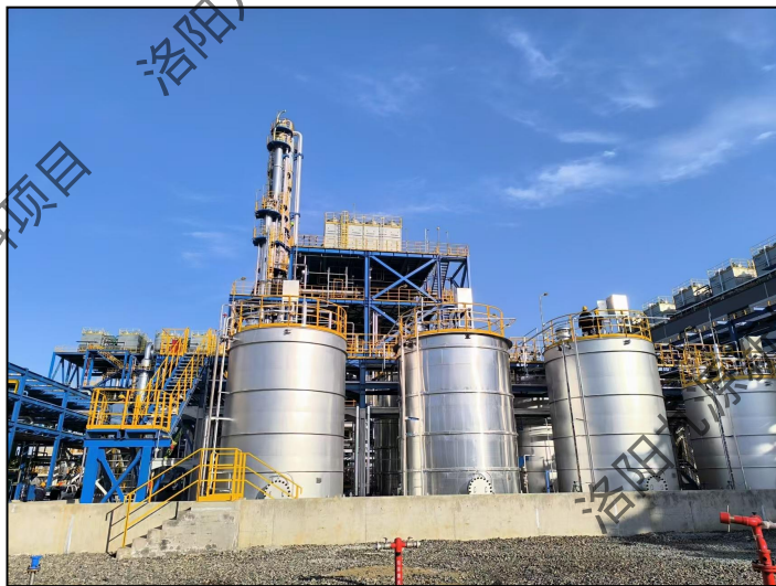
储罐区围堰
