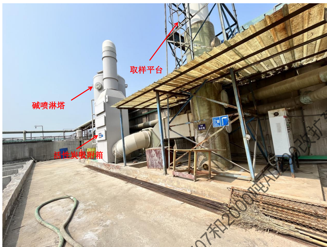
污水处理站废气处理装置
