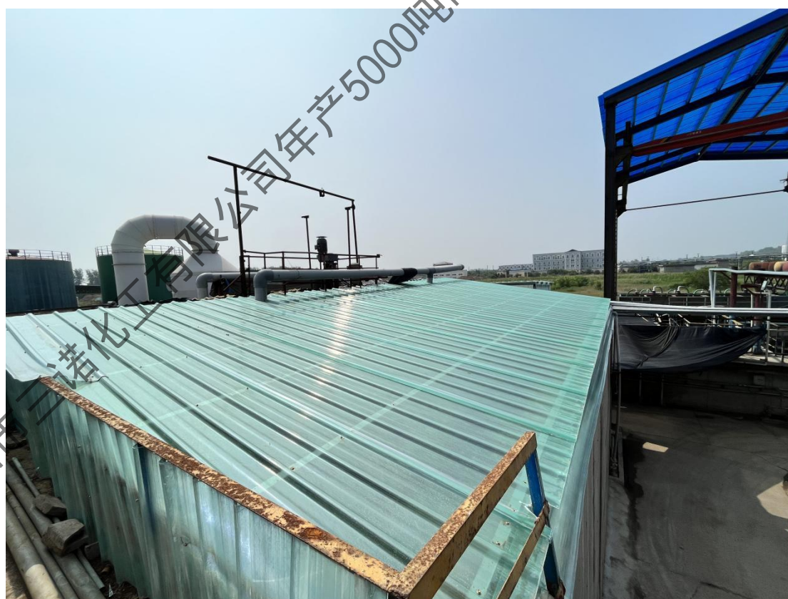
污水处理站槽池已加盖并设置废气收集装置
