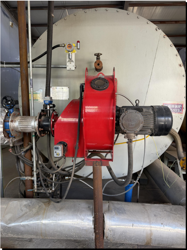
导热油炉及低氮燃烧器
