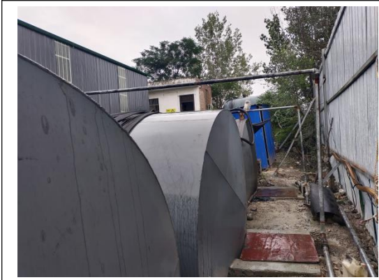
裂解油储罐及油气回收装置
