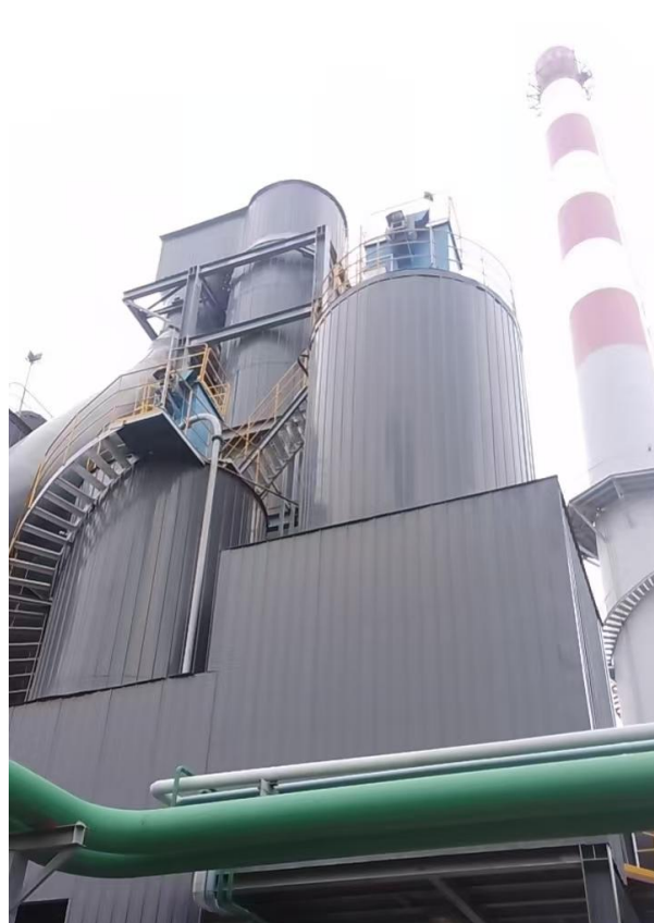
窑炉废气排气筒
